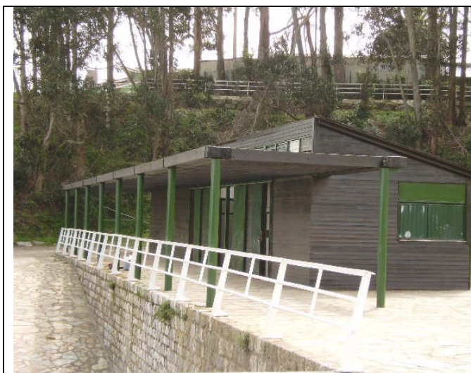
Vista general del edificio de servicios
